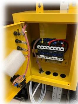
В состав модели G650EA- входит выносной блок автоматики (ATS) который позволяет автоматически запускать и останавливать генератор при отсутствии или появлении напряжения во входной электросети.
